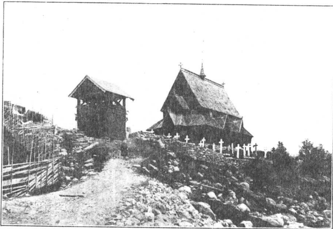
Gamle Reinli stavkirke
